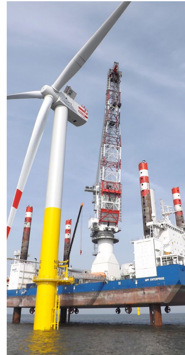
/ Norddergründe Offshore Wind Farm, Germany.
